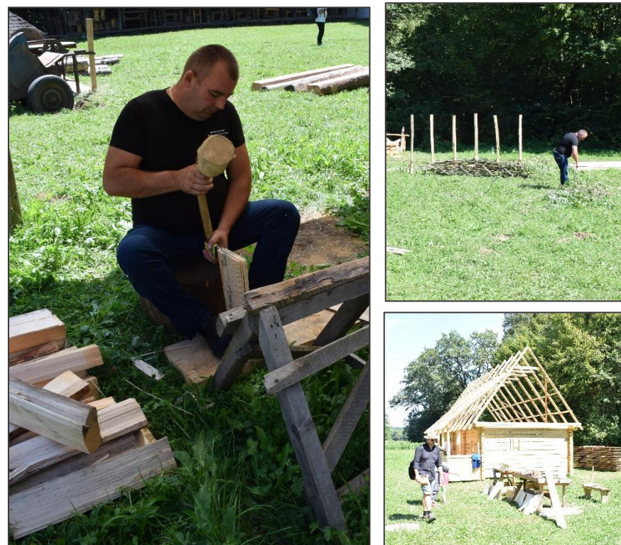
Figur 50: Museet var flink til å syna fram handboren kunnskap. Handverkarane bygde opp ein kopi av eit av husa og inviterte publikum til å sjå dei ulike prosessane og teknikkane dei brukte. Til venstre: Får vi ein innblikk i korleis ein laga spon til taket. Øvst til høgre: Ein smakebit på korleis ein laga eit tradisjonelt gjerde. Nedst til høgre: Her ser vi kopien av huset dei byggjer. Dette huset er til sals. Foto: Marie Pettersson
